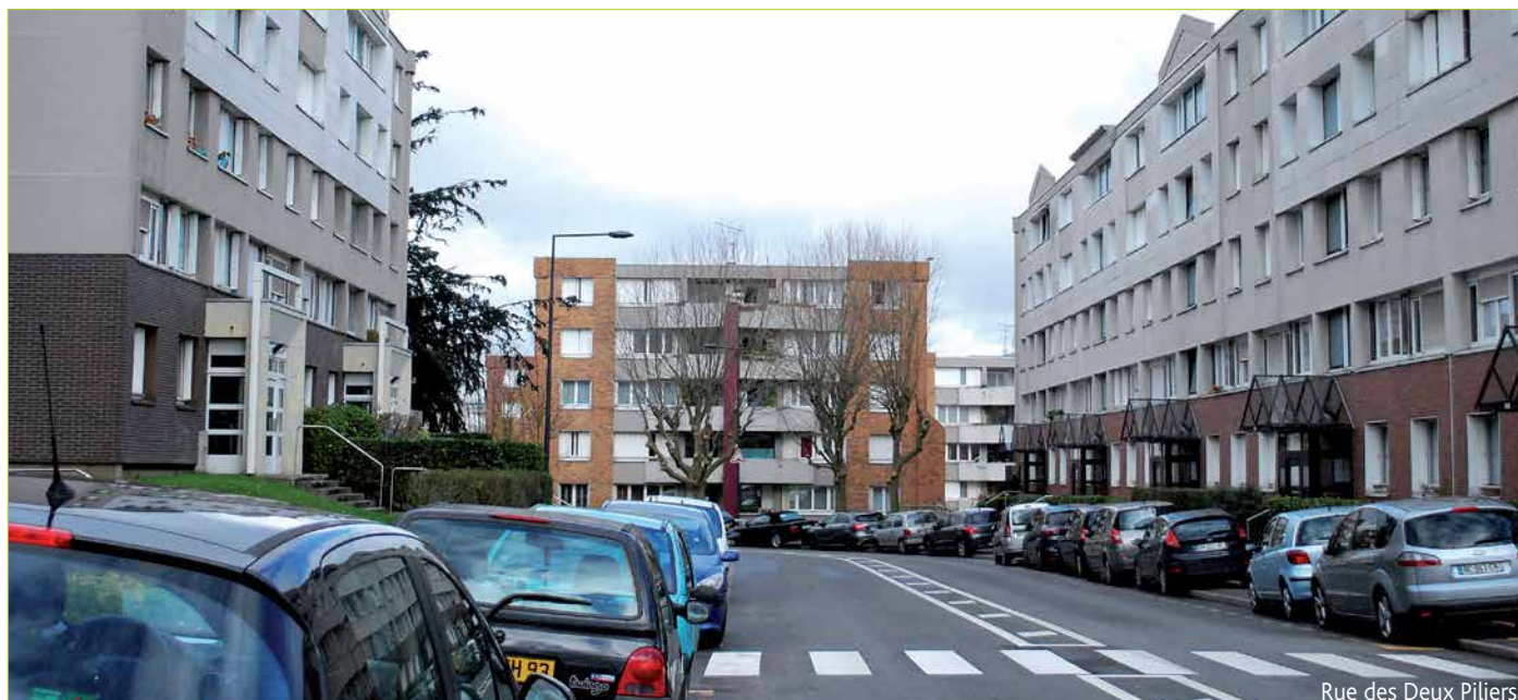
Rue des Deux Piliers
