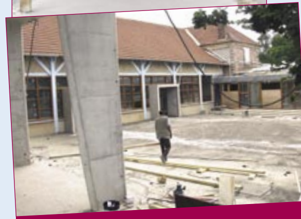
L'achèvement des travaux de l'école Jules Ferry est prévu pour l'année 2006.
