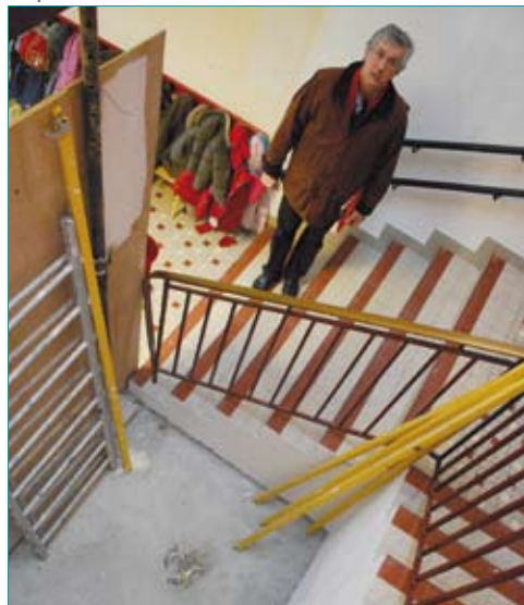
Emplacement du futur ascenseur
